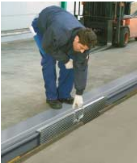
BB-Brücke aus der Führungsschiene herausheben.
